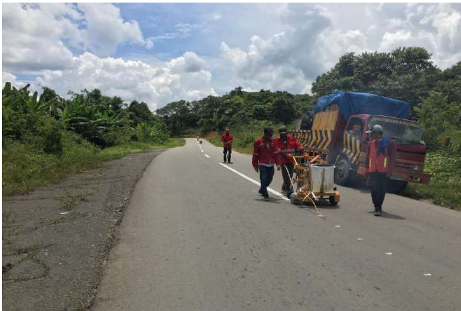
Pekerjaan Marka Jalan
